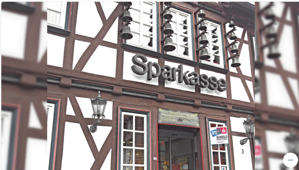
Außenansicht der Sparkasse in Gieboldehausen. FOTO: BB
