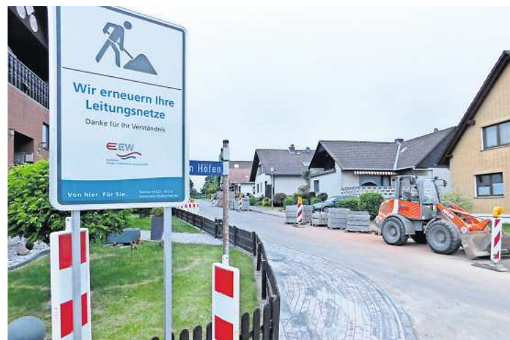
Bauarbeiten prägen derzeit das Bild „Über den Höfen“ und in angrenzenden Straßen.
